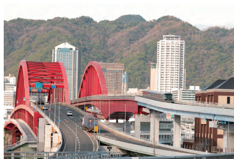
▲神戸大橋 (左) と並行してかかるポートピア大橋 (右) は、ポートライナー (神戸新交通ポートアイランド線) の専用橋。
